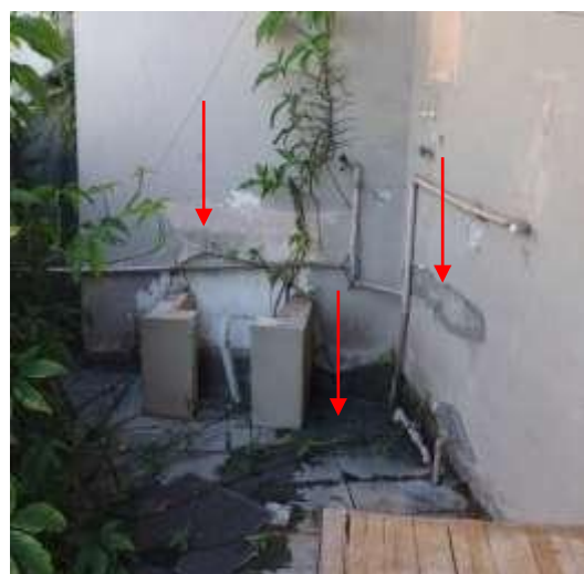
Figura 13 - ÁREA EXTERNA-EDIFICAÇÃO PRINCIPAL – FACHADA DOS FUNDOS: Indícios de vazamento de tubulações de água/esgoto. Avarias no revestimento argamassado, necessário verificação das instalações, acabamento adequado para as alvenarias e posterior repintura.
