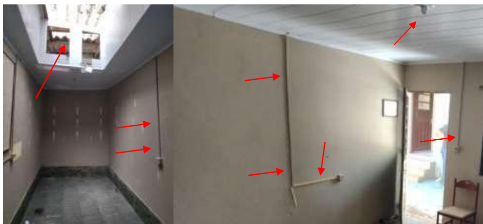
Figura 32 – ÁREA INTERNA – EDÍCULA: Instalações elétricas em desconformidade com as normativas vigentes,
