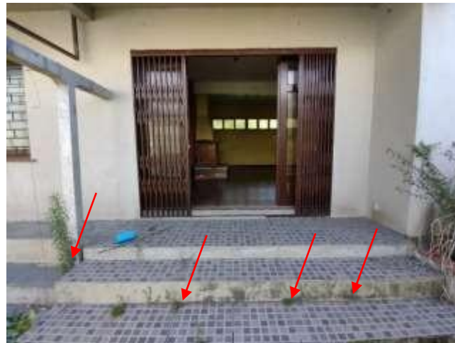
Figura 9 –ÁREA EXTERNA-PÁTIO DOS FUNDOS: Acesso da edificação principal para o pátio dos fundos, crescimento de vegetação entre as juntas de assentamento das cerâmicas externas, necessário limpeza, verificação da aderência das peças e posterior rejuntamento.
