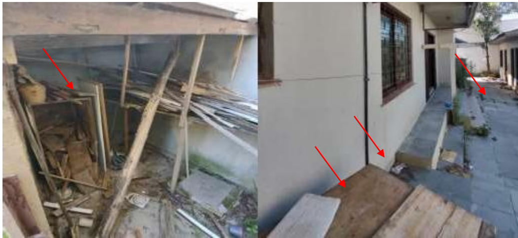
Figura 8 – ÁREA EXTERNA-PÁTIO DOS FUNDOS: Acúmulo de materiais (resto de obras), necessário realizar remoção e limpeza geral. Crescimento de vegetação entre as juntas do revestimento externo, necessário realizar a limpeza e orientamos realizar posterior rejuntamento.
