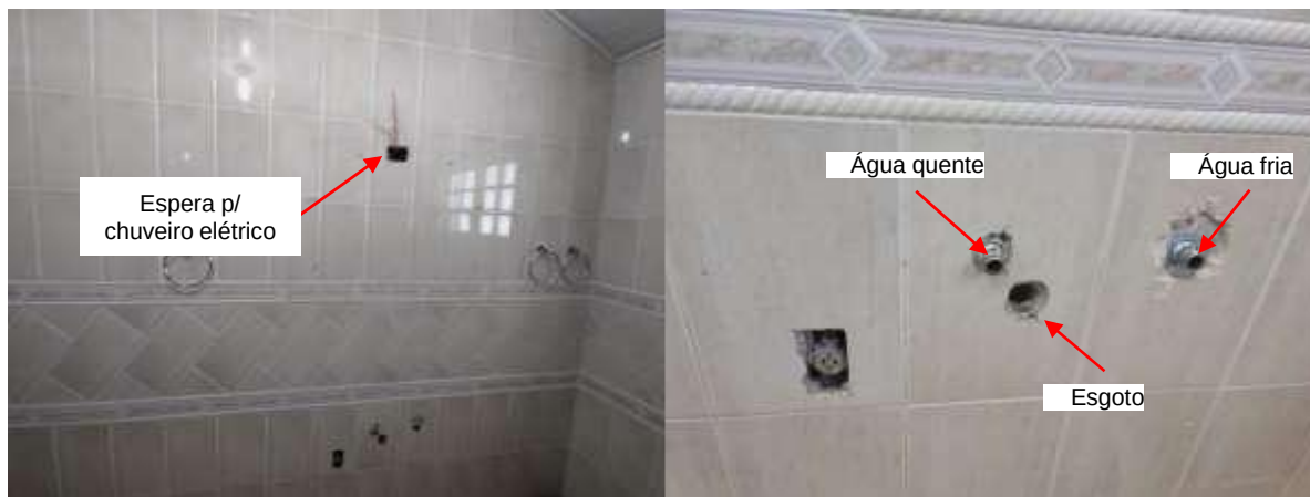
Figura 18 – ÁREA INTERNA – EDIFICAÇÃO PRINCIPAL SANITÁRIO: Condições atuais dos pontos de abastecimento de água fria / quente e esgotamento sanitário. Ponto de tomada inadequado, necessário adequação as
