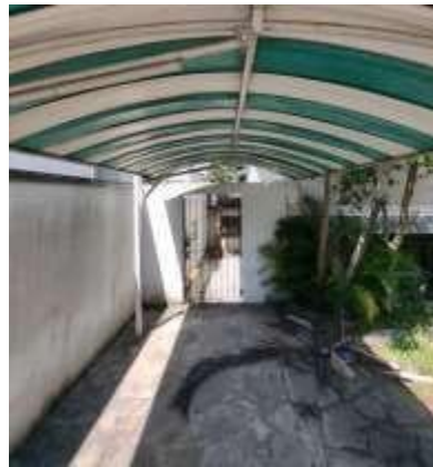
Figura 7 – ÁREA EXTERNA – FACHADA PRINCIPAL: Cobertura em toldo com estrutura
