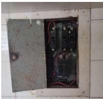
Figura 16 – ÁREA INTERNA – EDIFICAÇÃO PRINCIPAL: Quadro de distribuição localizado no pavimento térreo, em desconformidade com as normativas vigentes, necessário adequar as instalações.
