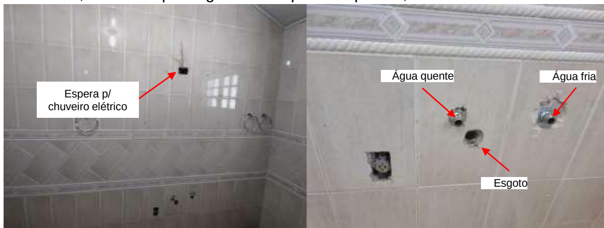
Figura 17 – ÁREA INTERNA – EDIFICAÇÃO PRINCIPAL: Sistemas de extensão de rede de energia elétrica para adaptação de pontos de tomada, caixas de passagem sem tapas adequadas, acabamento
